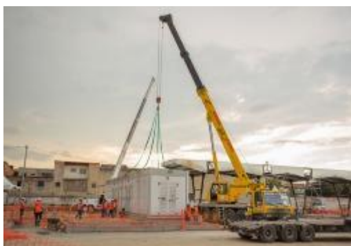
(a) Instalación de la mini 49 subestación 50 en el depósito de autobuses (b) mejora del depósito de autobuses (c) 51
