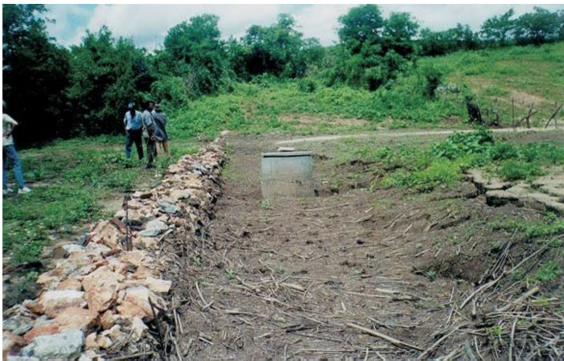
Foto M – Vista de uma barragem subterrânea terminada. Note-se o cacimbão feito de anéis de cimento e o barramento de pedra que marca o local onde está a valeta com a lona enterrada. Photo M - View of a finished underground dam. Note the cacimbão made of cement rings and the stone dam that marks the place where the ditch with the buried tarp is 316
