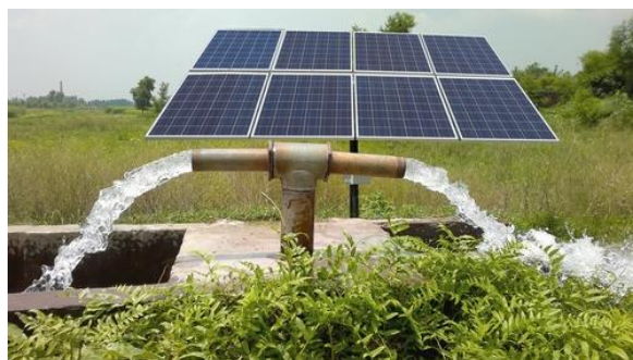
Figura 6.9: Captação de água em furo com fonte de alimentação solar
